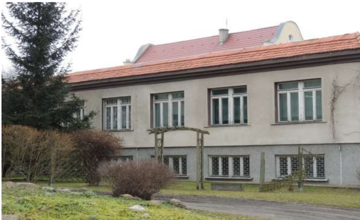
Fot. 2. Widok na gmach Szkoły Podstawowej nr 1 im. Stanisława Staszica w Szamotułach od strony boiska.
