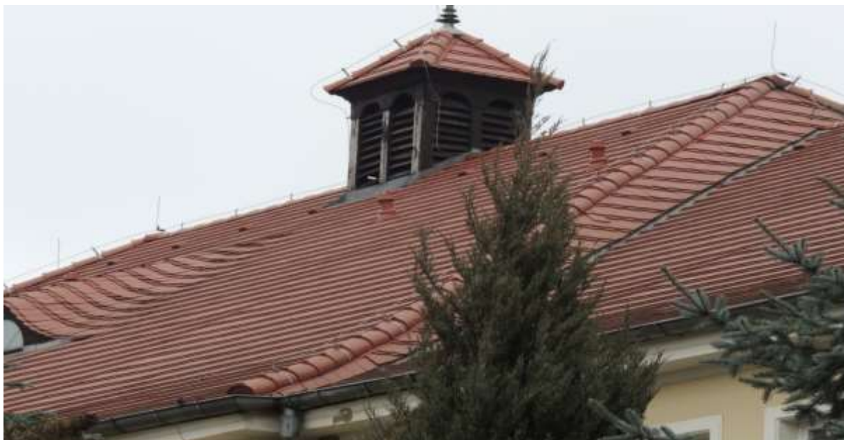
Fot.3. Konstrukcja dachowa starej części Szkoły Podstawowej nr 1 w Szamotułach. Ta część budynku nie podlega planowanej inwestycji.
