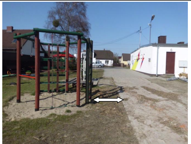
Zbyt mała odległość chodnika - należy rozebrać chodnik i uzupełnić piasek pod drabinką
