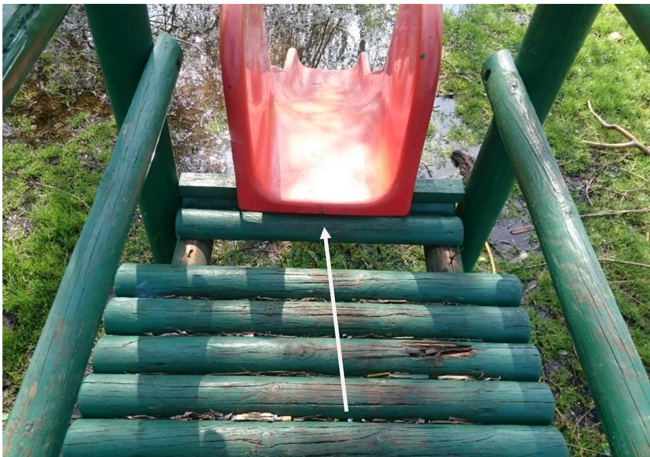
Pęknięcie zjeżdżalni
